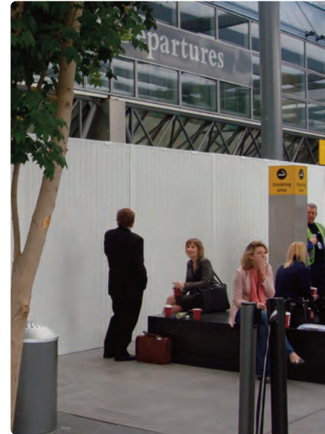
Installation auf einem großen internationalen Flughafen
