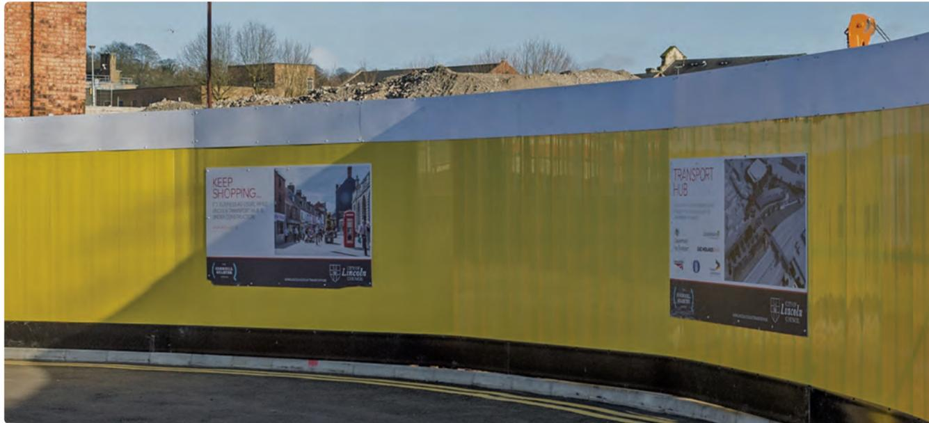
Go-Hoard™ ist der innovative PVC-Zaun, der aus recyceltem Material hergestellt wird. Er ist eine hervorragende Alternative zu Holzzaunen (die anfälliger für Witterungsschäden und Vandalismus sind). Go-Hoard™ ist ein robuster, ordentlicher, wiederverwendbarer und recycelbarer Zaun von 2 m und 2,4 m Länge.
